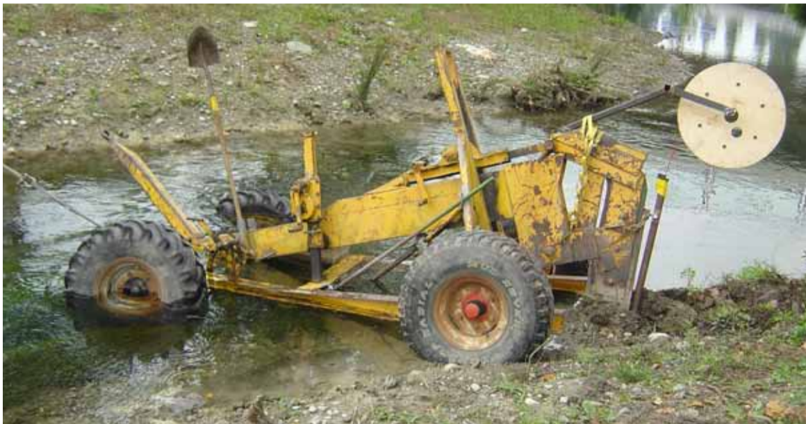
Abb. 2: Spezialflug zum Verlegen des Kabels im Bachbett.
