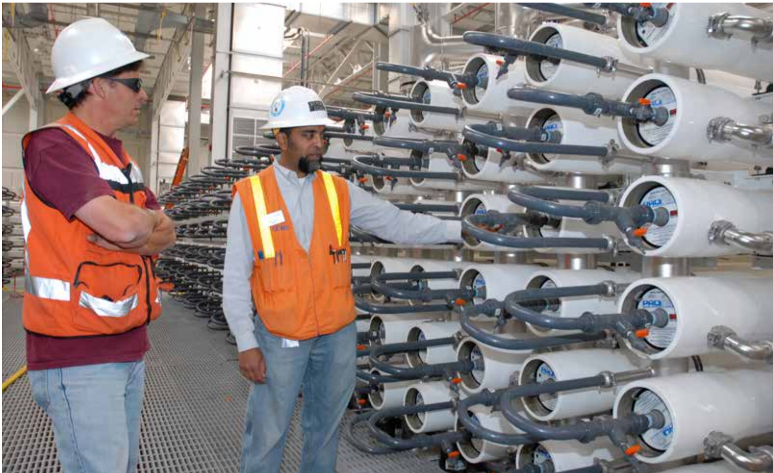
Fig. 1 : La société californienne d'approvisionnement en eau « Orange County Water District » produit de l'eau potable à partir des eaux usées. Contrairement à d'autres projets similaires envisagés dans cet Etat, son concept n'a pas rencontré d'opposition de la part de la population. Sur la photo : l'unité d'osmose inverse.
