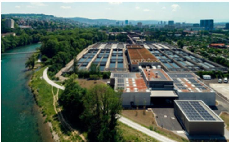
Les stations d'épuration des eaux usées (la photo montre la STEP de Werdhölzli) possèdent un grand potentiel de récupération d'énergie. La chaleur extraite des eaux usées traitées est injectée dans un réseau de chauffage urbain.
