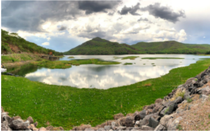
Les jacinthes d'eau se rassemblent dans un lac de retenue de la centrale hydraulique «Kafue Gorge Power Station» en Zambie. (Photo: RS Winton)
