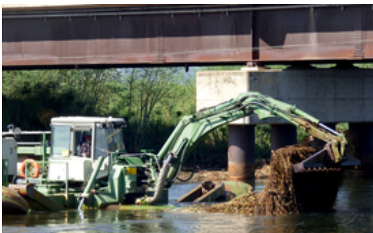
Les plantes aquatiques flottantes sont retirées sur un pont au-dessus de la centrale
