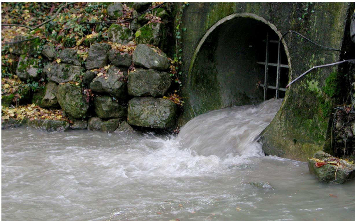
Un débordement caractéristique d'eaux mixtes à cause duquel l'eau de pluie et les eaux usées domestiques doivent être déversées dans un cours d'eau pour désengorger les canalisations (Photo: Centre Écotox).
