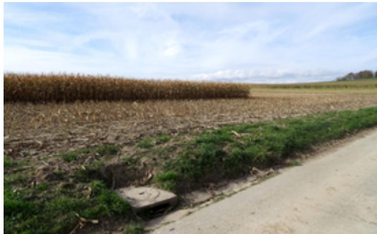
L'eau provenant du champ et du chemin agricole est acheminée par de telles bouches d'égout directement dans le cours d'eau le plus proche - un court-circuit hydraulique.
