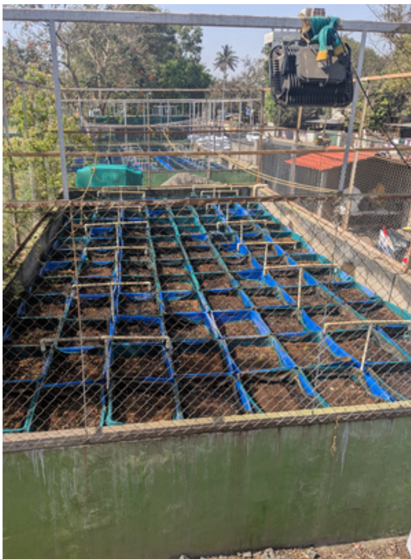
Installation du vermifiltre à Pune, Inde (photo : Kayla Coppens, Eawag).
