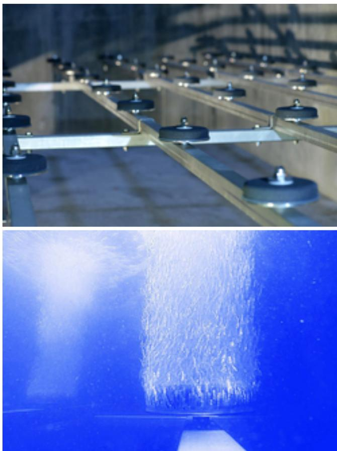
L'ozonation est une méthode éprouvée pour extraire des micropolluants de l'eau. Sur la photo: des diffuseurs d'ozone dans la STEP Neugut à Dübendorf. La STEP Neugut est la première grande installation suisse à utiliser l'ozonation pour éliminer des micropolluants.
