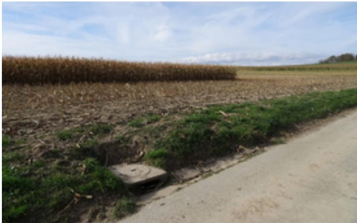
**L'eau provenant du champ et du chemin agricole est acheminée par de telles bouches d'égout directement dans le cours d'eau le plus proche - un court-circuit hydraulique.
