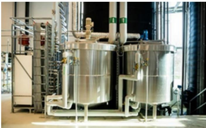
À gauche: installation de fermentation de HAMBURG WATER Cycle, dans laquelle les matières fécales transportées dans des conduites sous vide sont utilisées pour la fabrication de biogaz. (Photo: Krafft Angerer / HAMBURG WASSER)
