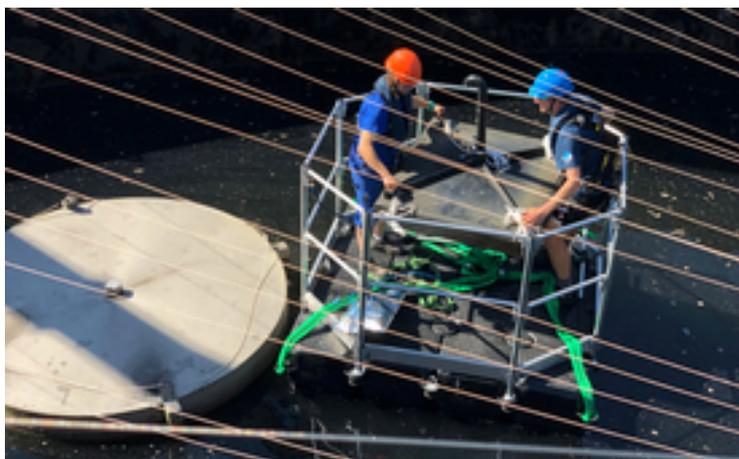
**Des chercheurs de l'Eawag pendant le montage du dispositif de mesure des effluents gazeux.**
