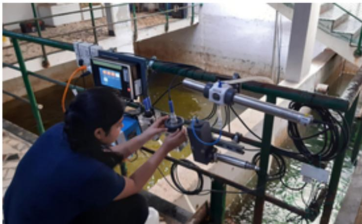
**Pour améliorer la qualité de l'eau recyclée, les chercheuses et chercheurs recommandent d'automatiser la chloration à l'aide de capteurs en ligne, tels que ceux installés sur la rampe du réservoir de stockage de l'eau traitée pour la chasse d'eau des toilettes.**
