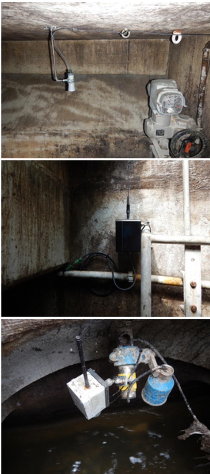
*Fig. 2 : Les capteurs radio fournissent aux chercheurs des mesures spatiales et temporelles haute résolution des écoulements et des niveaux d'eau.*
