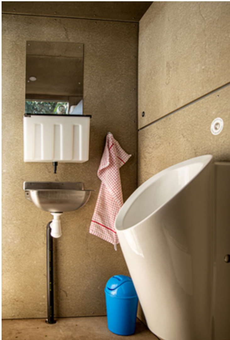
Urinoir et lavabo dans le cabanon de toilettes Blue Diversion Autarky à Durban. La toilette à séparation n'est pas visible. Photos: Autarky, Eawag
