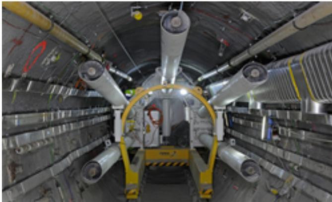
Vue sur l'intérieur de la galerie FE. Au premier plan, un conteneur de stockage final muni d'un système de chauffe qui lui permet de simuler un conteneur réel renfermant des éléments combustibles usés dégageant de la chaleur de désintégration. Les tubes en forme de cigarette font partie de la machine de remplissage du tunnel ; ils permettent de déverser la bentonite à l'endroit voulu. (Photo: Nagra)
