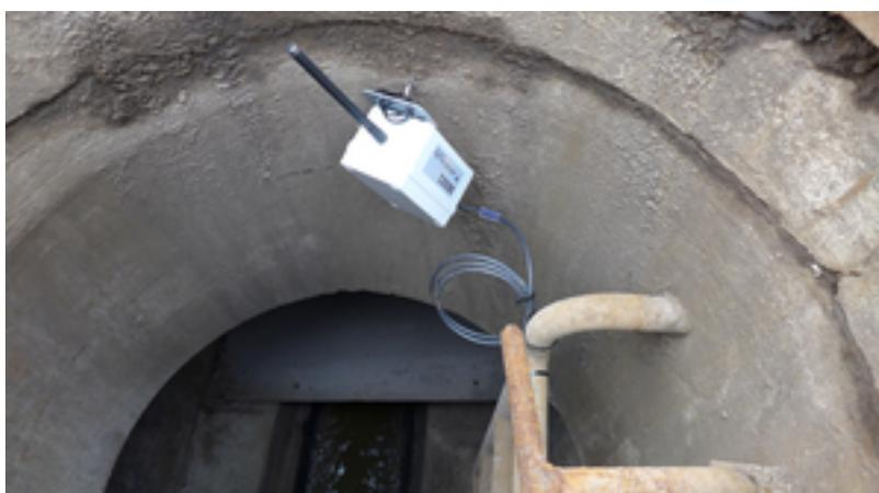
*Capteur de niveau dans la bouche d'égout avec transmission radio
